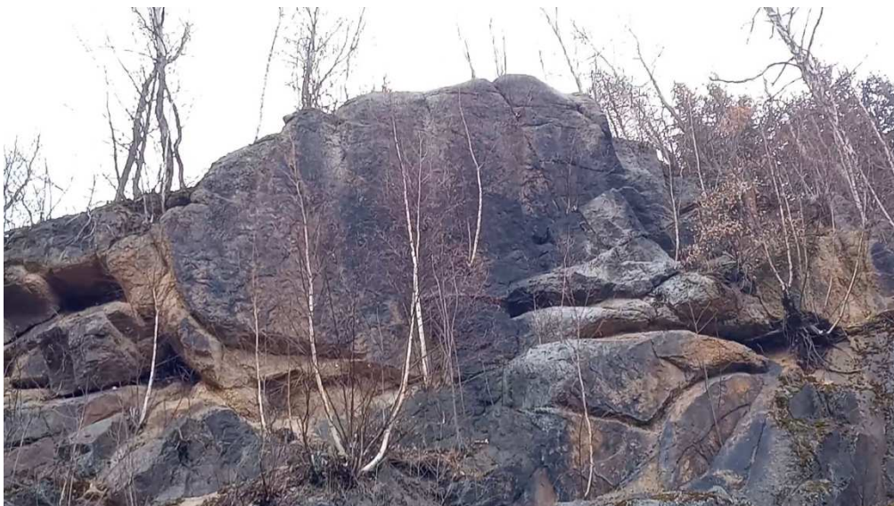
Koncový úsek odřezu tvořený hrubě libereckou žulou s hrubě blokovitou strukturou a stupňovitou morfologií svahu (zajištění proběhne instalací kotvené dvouzákrutové sítě s vel. oka 80 x 100 mm).
