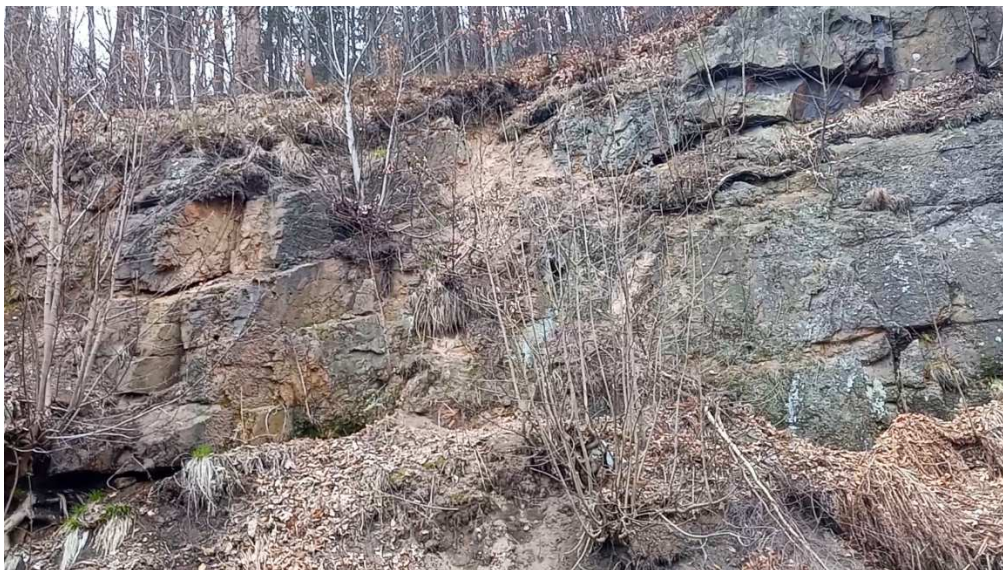
Silně zvětralý až rozložený skalní podklad charakteru perku (sanace proběhne instalací kotvené dvouzákrutové sítě s vel. oka 80 x 100 mm extrudovanou PP 3D protierozní rohoží).
